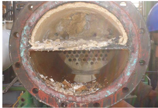
Figure IV.3: Les tartes formées sur la boîte de distribution
