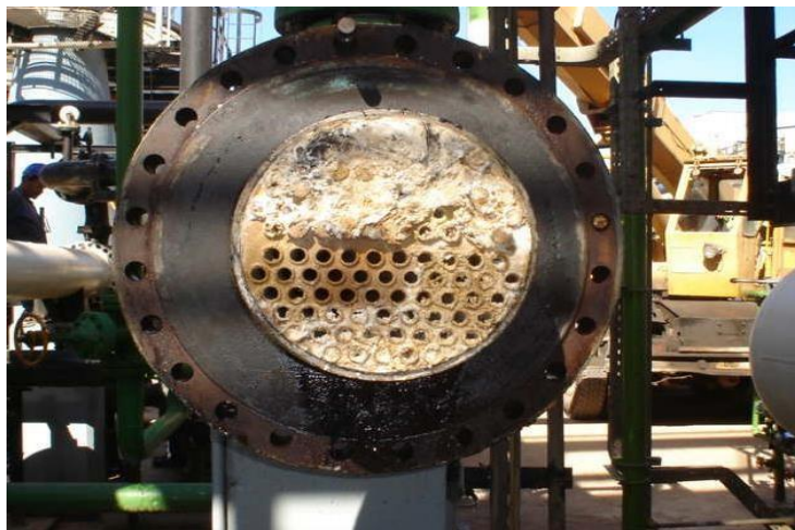
Figure IV.2 Le bouchage du faisceau tubulaire de l'échangeur E-504
