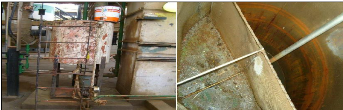
Figure II.3. Photographie de la pompe doseuse d'anti-mousse.
