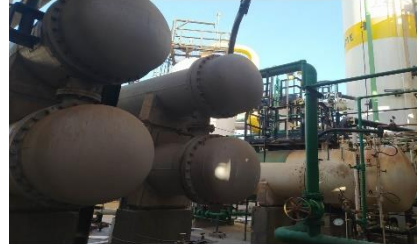
Figure I.6. Les échangeurs de MEA 233-C.
