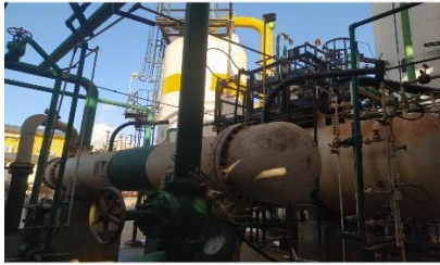
Figure I.5. Refroidisseur de MEA 232-C.
