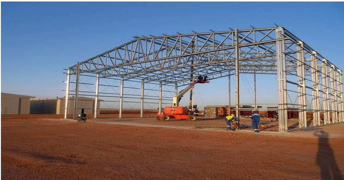
Figure II .1 : Hall métallique en construction [18].
