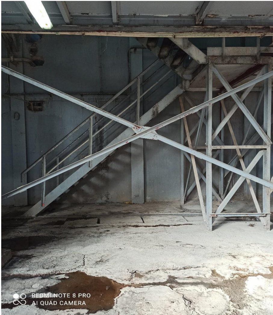
Figure III. 8 : Les diagonales de contreventement horizontal.
