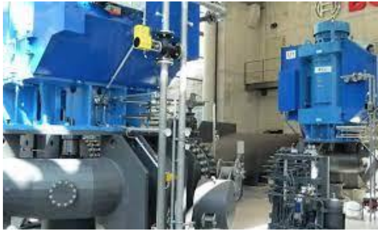
Figure IX-3 Turbine de Francis à axe vertical [14]
