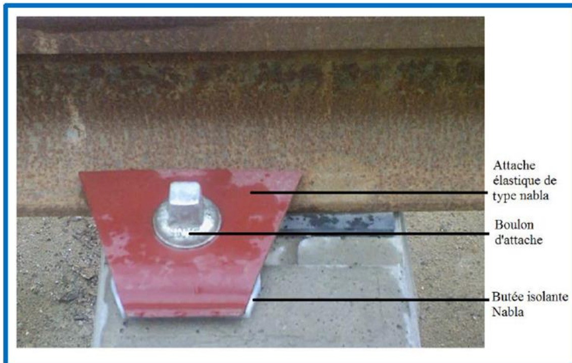
Figure 07-16 : Les éléments d'une attache de type Nabla.
