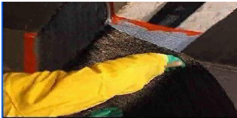
Figure I-16: Mise en place de la bande ou du tissu
