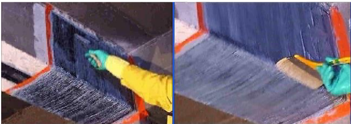
Figure I-17: Mise en place d'une couche de résine d'accrochage sur la surface extérieure
