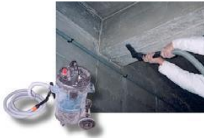
Figure I-14: Nettoyage et brossage des surfaces qui peuvent être humides
