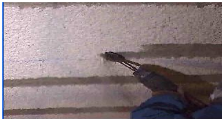
Figure I-13: Préparation du support
