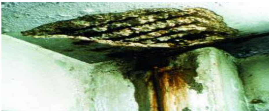
Figure II-1: La corrosion de l'acier d'armature
