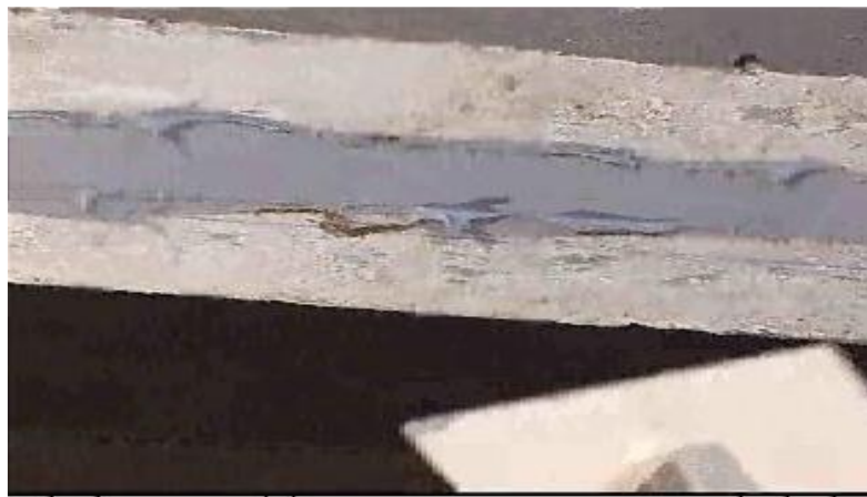
Figure I-15: Préparation des fissures par injection de la résine de réparation
