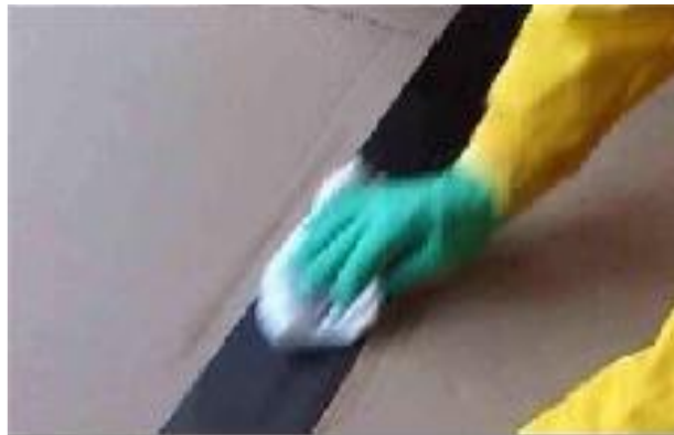
Figure I-20: Préparation de la surface du renfort
