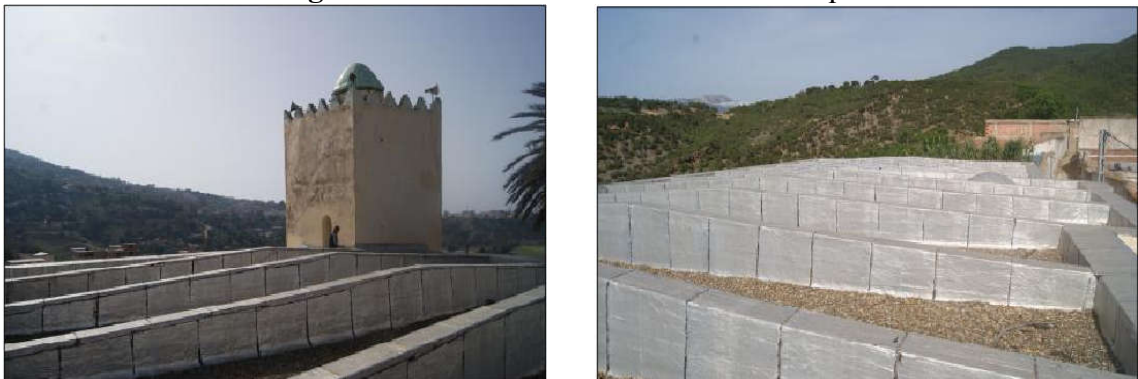
Fig. 3.12 - Vus de toiture de la mosquée.
