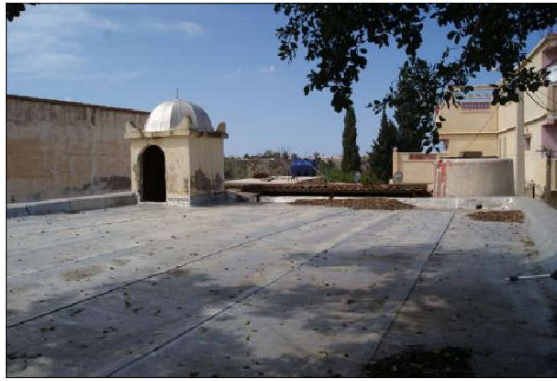
Fig. 3.17 - Vue de la toiture.
