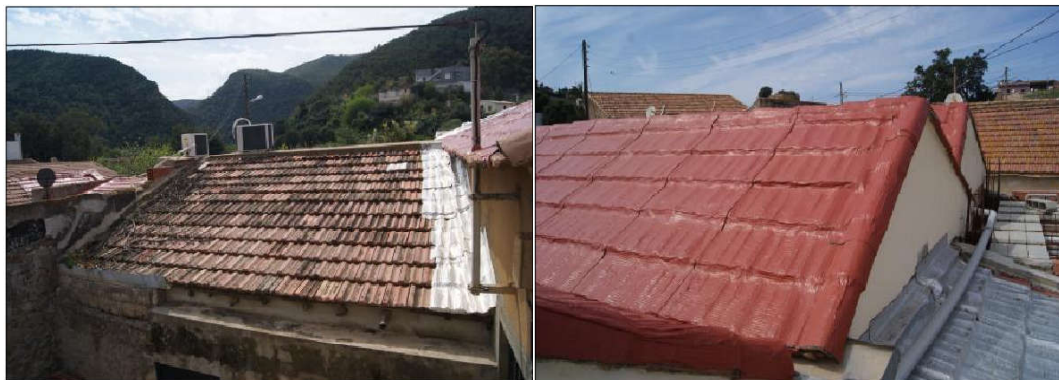
Fig. 3.23 - Vus de la toiture.
