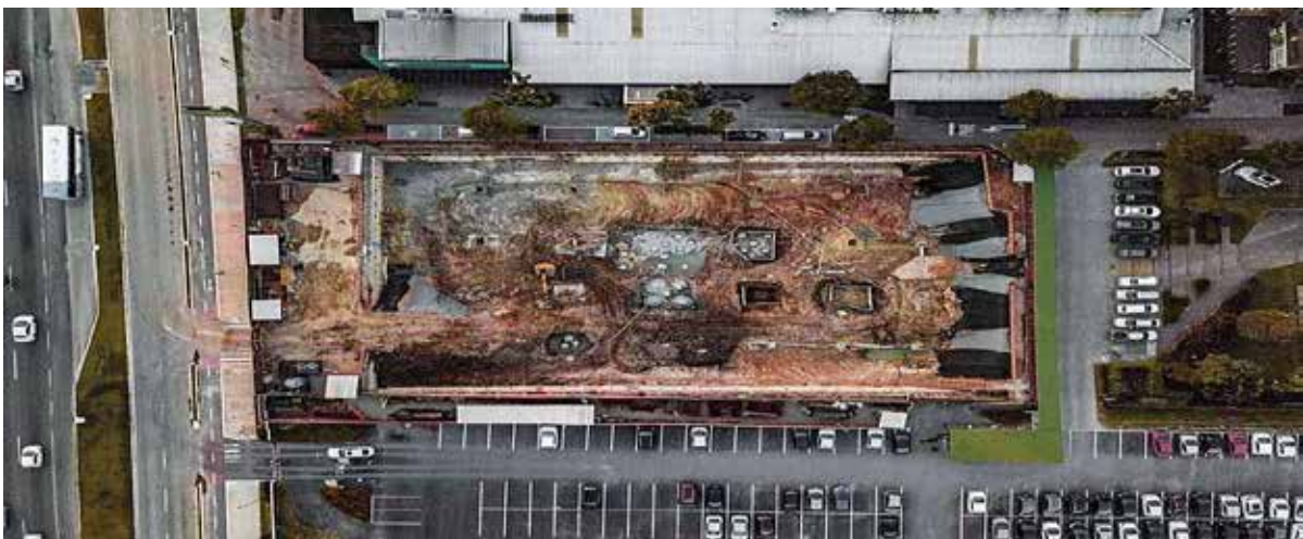
Figure II.4 : photographie aérienne de chantier
