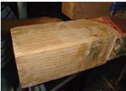
Figure III.39 : Remplacement du bout pourri d'une solive en bois malade avec un morceau de bois neuf
