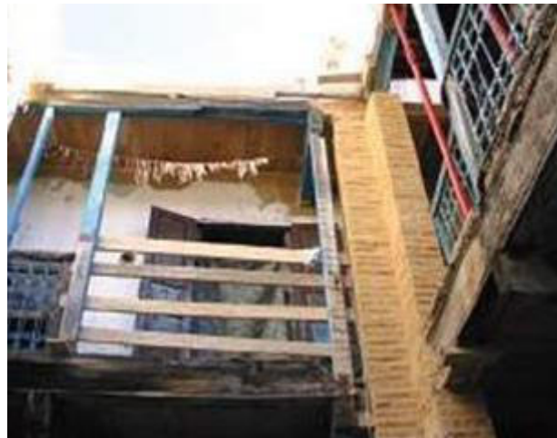
Figure III.32 : Reconstruction d'un pilier dégradé en briques pleines traditionnelles
