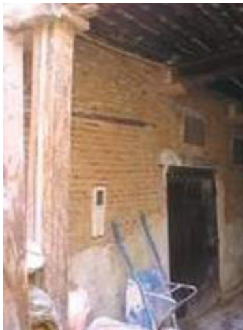
Figure III.31 : Reconstruction de la partie dégradée d'un mur [35].
