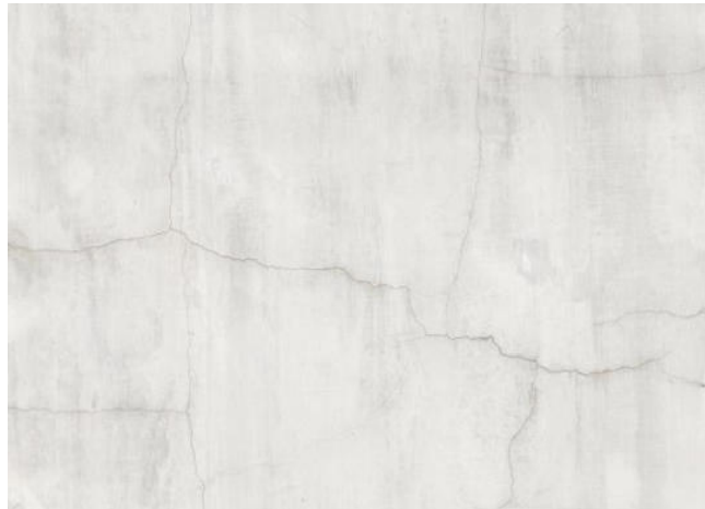
Figure I.1 : Faïençage dans un enduit de façade, avec un réseau de microfissures [7].
