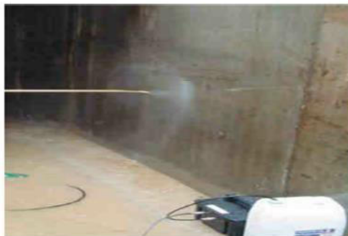
Figure III.30 : Mise en place d'un revêtement de surface [37].
