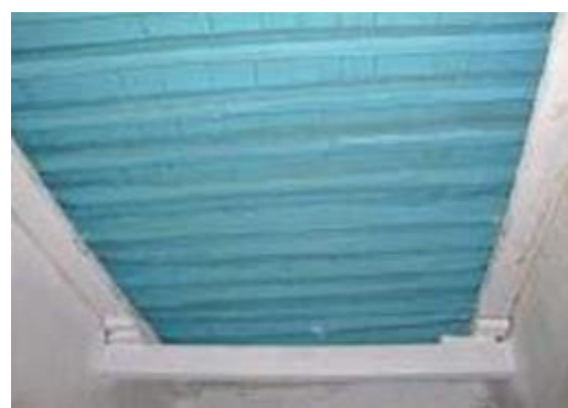
Figure III.40 : Les solives dont les bouts sont pourris reposent sur de nouveaux appuis en madriers de bois.
