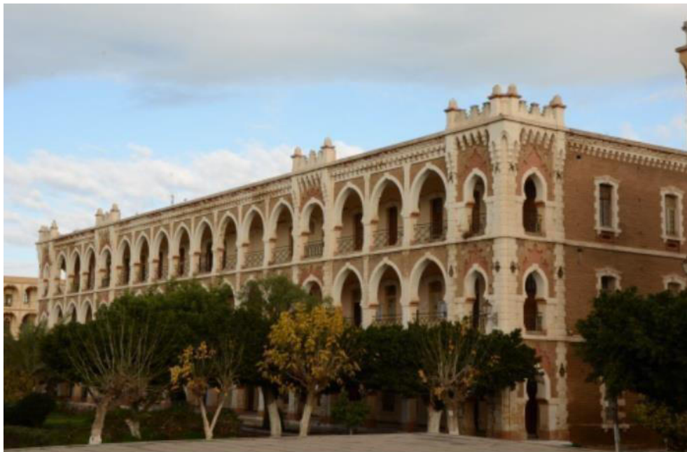
Figure IV.1 : Vue de façade de la structure à l'époque
