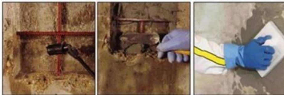
Figure III.3 : Gauche à droite ; Aciers dégagés, Application du mortier, Finissage par taloche [33].
