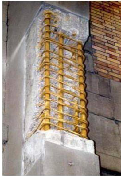
Figure III.11 : Réfection des bétons et protection des armatures [53].
