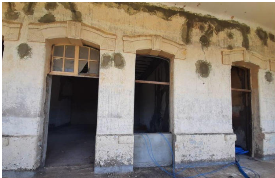
Figure IV.20 : Après la modification de la porte
