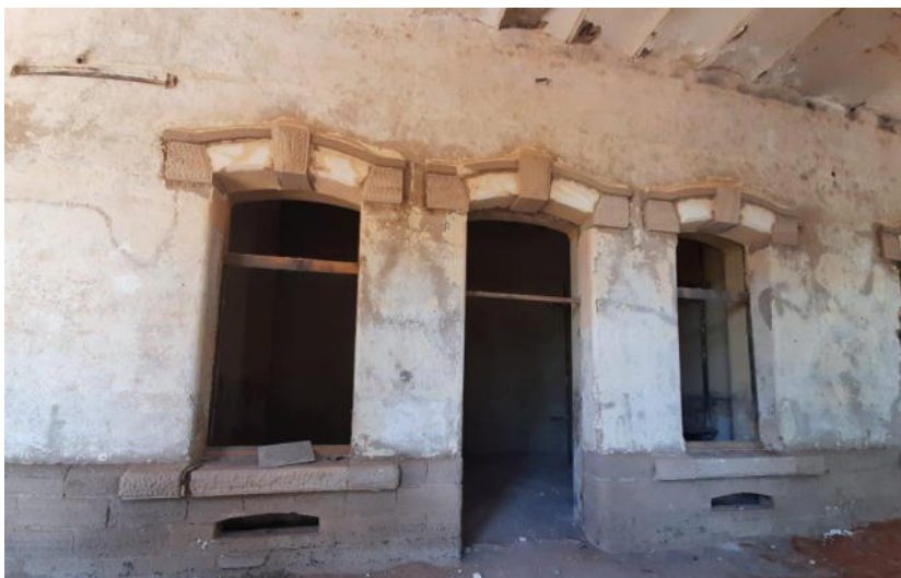
Figure IV.19 : Avant la modification de la porte
