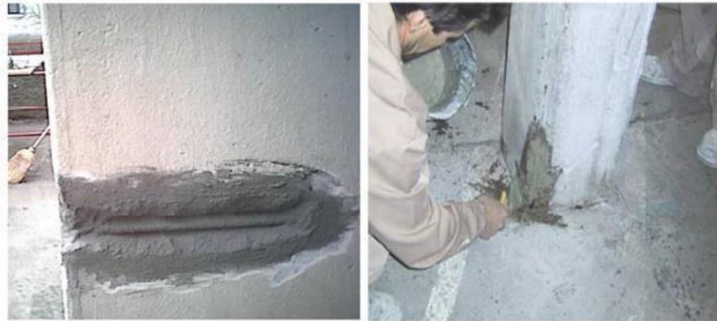
Figure III.23 : Réparation du béton [37].
