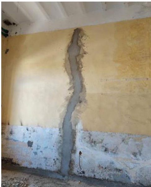
a) Traitement des fissures verticales
