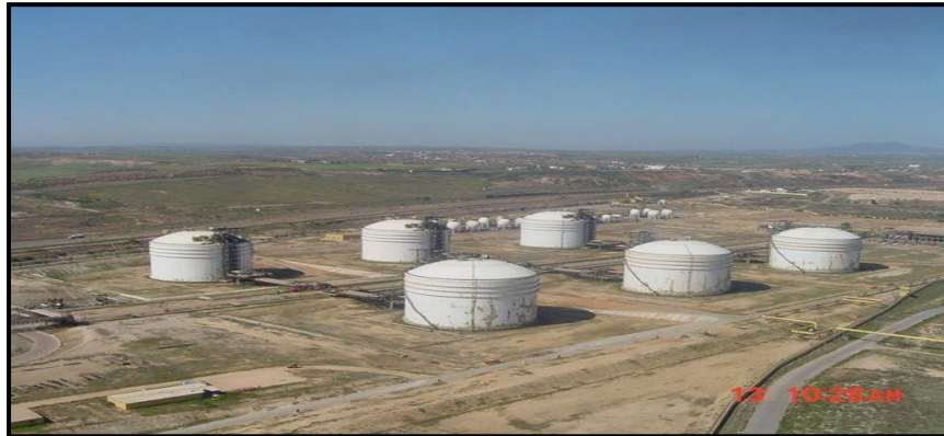
Figure I.4 : Bacs de stockage.
