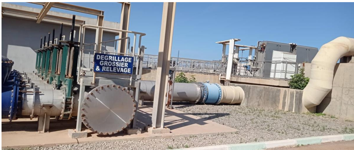
Figure 04 : dégrilleur (Berdadi.S et Bettaher.S ,2022)
