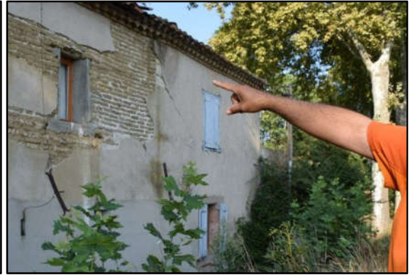
Figure I-17 : L'effet de l'affaissement de sol : Plantation d'arbre. [15]
