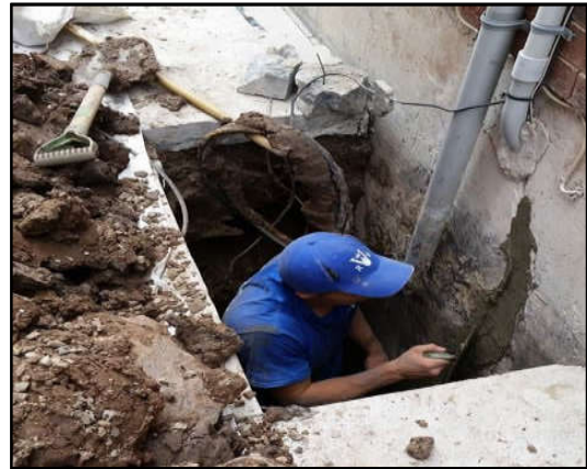
Figure I-18 : L'effet de l'argile gonflante : Infiltration d'eau. [15]
