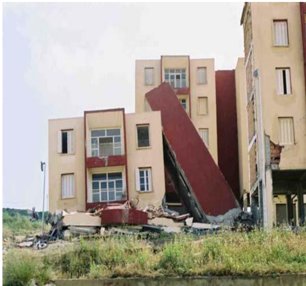
Photo 5 : transparence du réez de chaussée (DELLYS)
