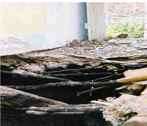
Photo 7 : les plancher en tronc d'arbre et les arcs faibles (DELLYS)
