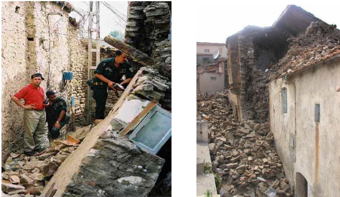
Photo 8 : les murs d'origine moellon (DELLYS)
