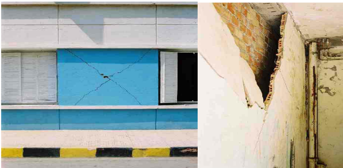
Photo 11 : Les ouvrages en maçonnerie de l'hôpital (DELLYS)
