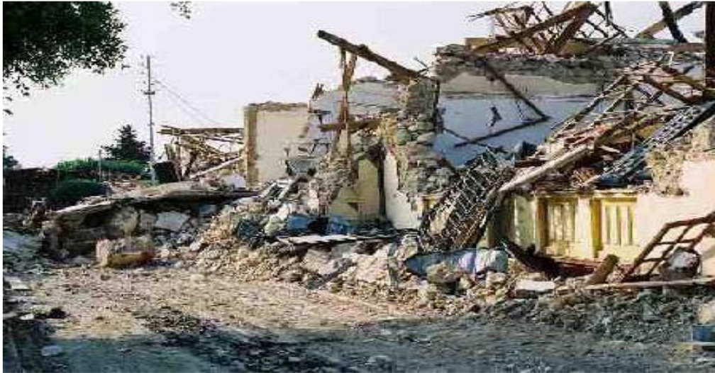
Photo 10 : construction en ferme en bois et murs épais (ZEMMOURI)
