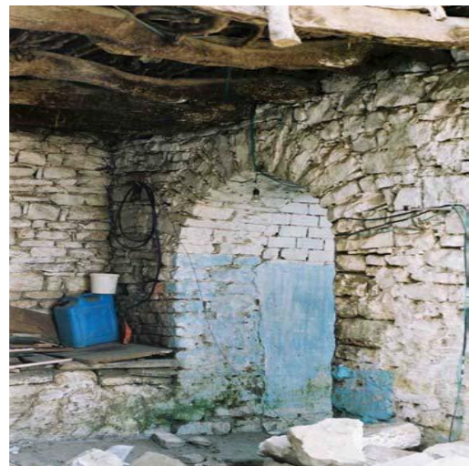
Photo 7 : les plancher en tronc d'arbre et les arcs faibles (DELLYS)
