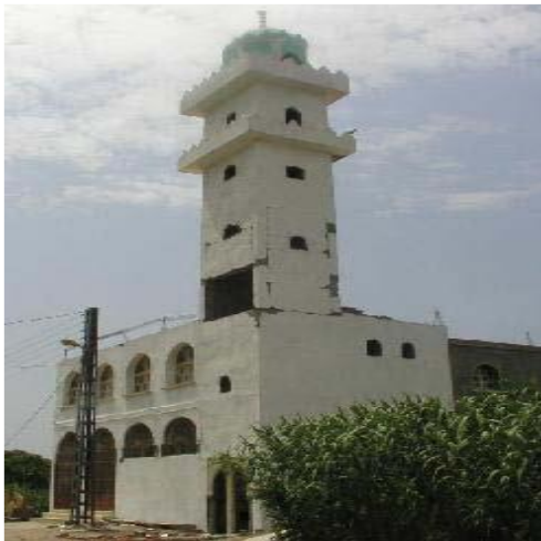
Photo13 : l'endommagement des minarets (CAP GINET)
