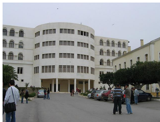
Photo 2 : construction a usage d'équipement. Qui situé a l'intérieure de la zone d'étude cette photo prise a partir de la ville de Mostagane
