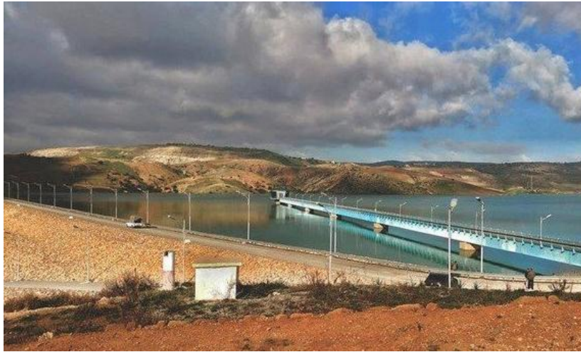
Figure3.3 : Barrage d'eau a mostaganem
