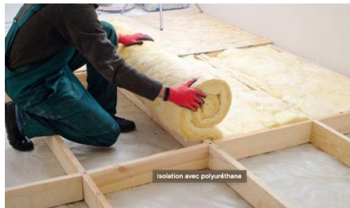
Figure 4.2 : isolation avec polyuréthane
