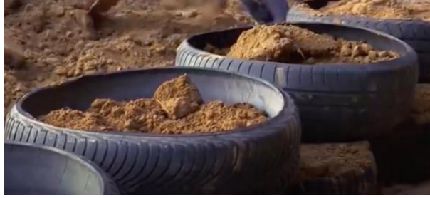
Figure 4.7 : pneus rempli de terre
