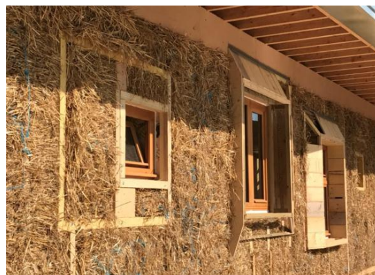
Figure 4.6 : Isolation d'une maison en paille
