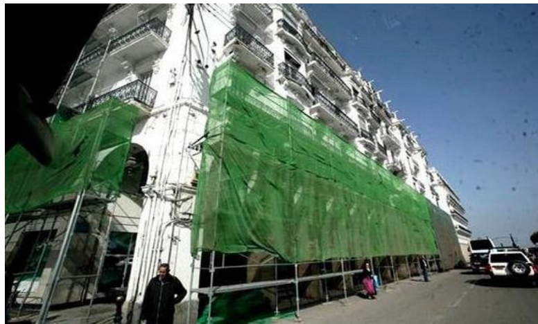
Figure 3.9 : Réhabilitation des façades à Alger
