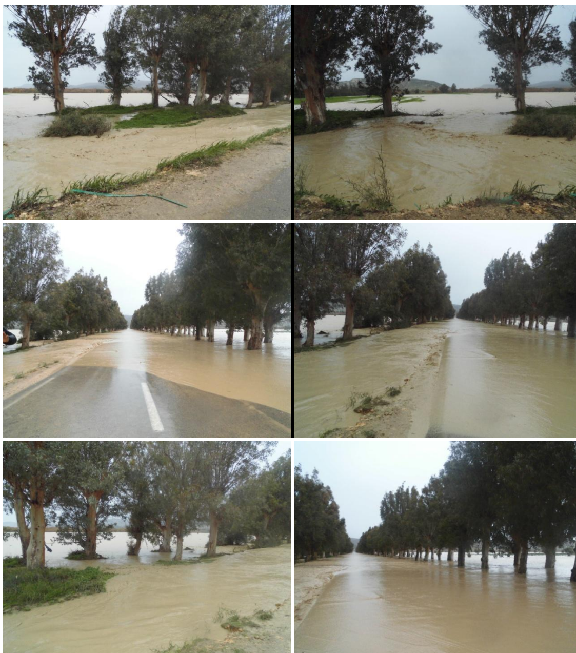
Débordement d'oued Chlef sur les terrains agricoles et la route
