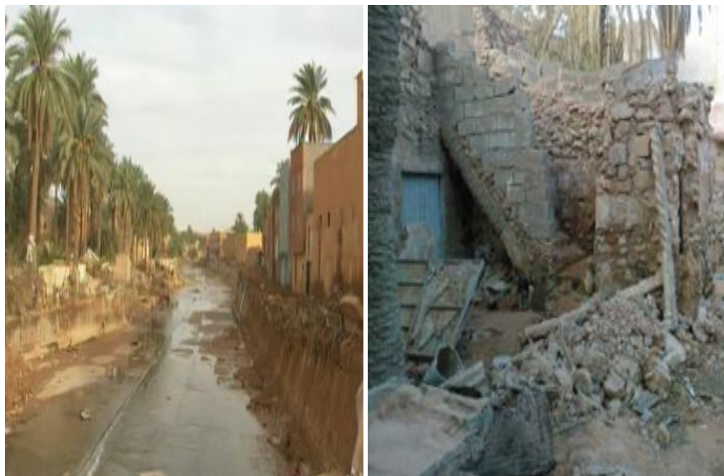
Figure III.22: Les dégâts d'oued Mzab
