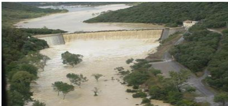
Figure 5- Exemple d'une rupture de barrage
