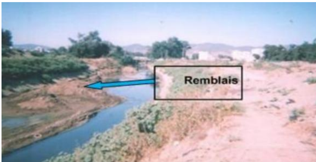
Figure 27- Le jet des remblais dans les cours d'eau aboutit à des inondations liées aux embâcles (Oued Zeramna prêt de la zone industrielle -Skikda -août 2005) (Boulghobra, 2006).
