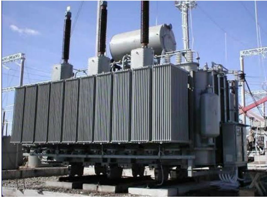
figure 24 : Réactance shunt 220 kV immergée dans l'huile
