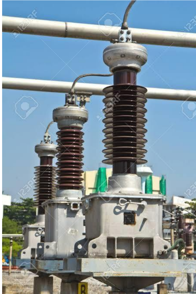
figure 14 : Disjoncteur 400 kV
