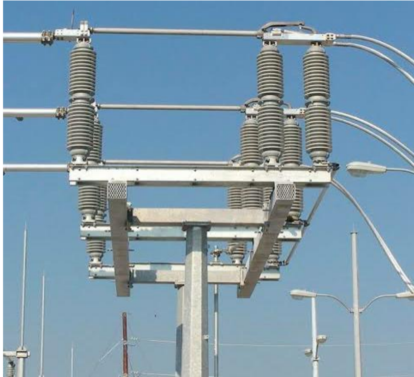
Figure 12 :Sectionneur à haute tension à isolement dans l'air
