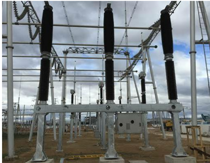
Figure 16 : disjoncteur à air comprimé
