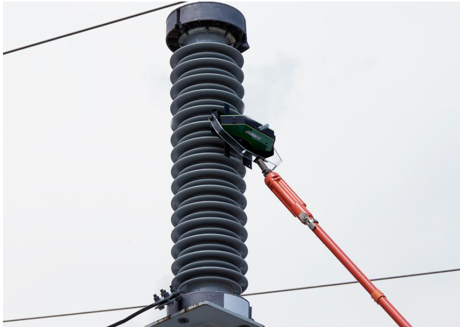
Figure 20 : Parafoudre à varistance sur ligne de transmission 110 kV.
