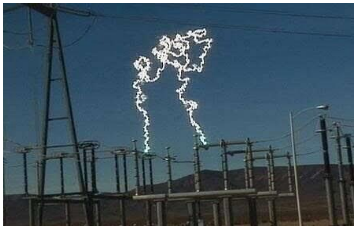
Figure 15 : arc électrique à un sectionneur
