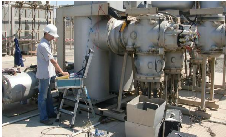
Figure 19 : disjoncteur auto-soufflage
