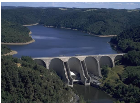
Figure 8 : Production d'énergie par barrages
