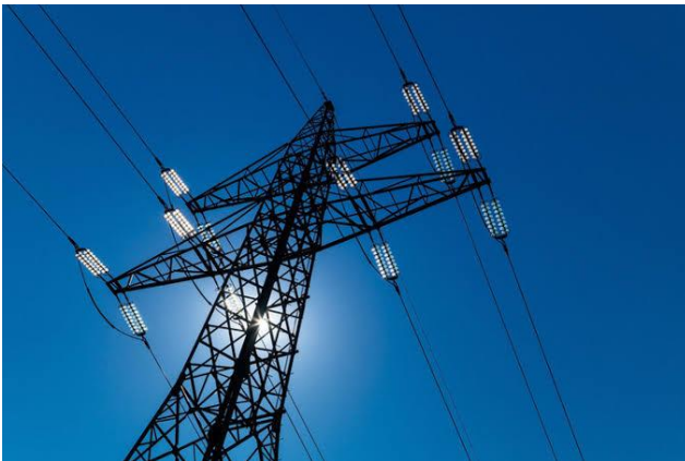
Figure 2 :Départs de lignes de distribution à 60kV.
