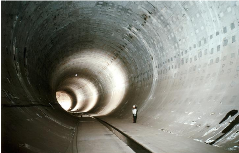
Figure V.3 : Vue intérieure du réservoir d'eau courante, Le réservoir peut contenir 540 000 tonnes d'eau de crue 42
