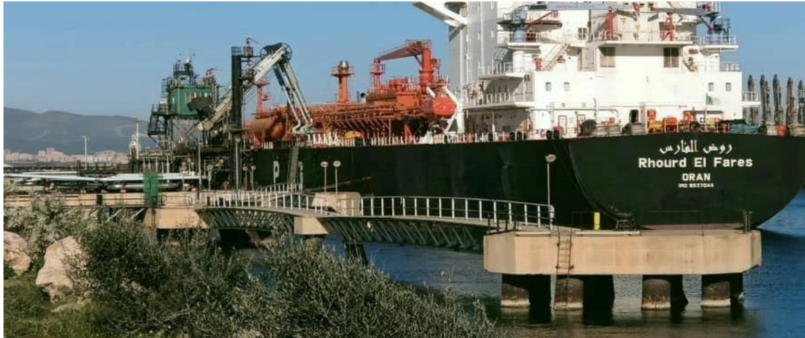
Figure II.12 : Quai de chargement de navire du GPL1/Z [12]
