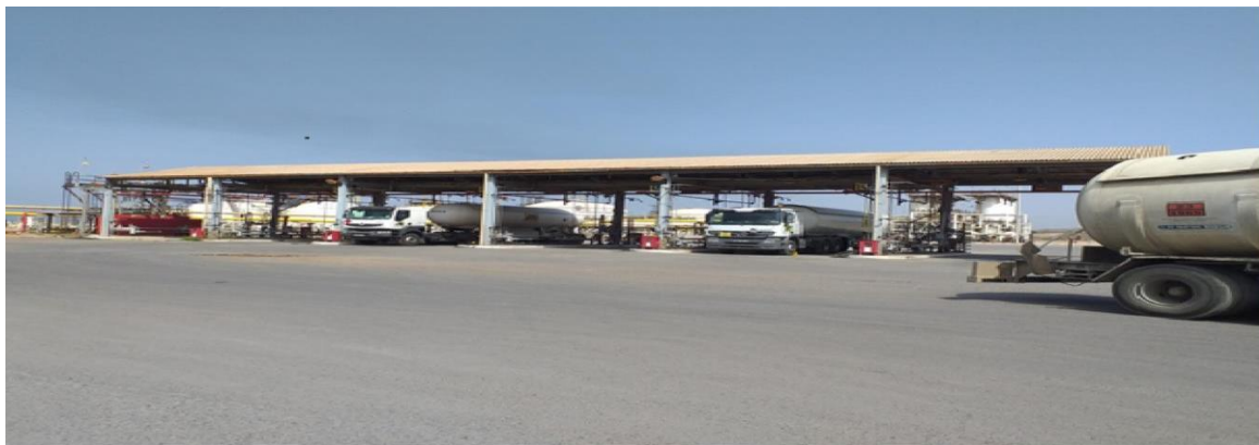
Figure II.15: Rampe de chargement de camions du GPL1/Z [12]
