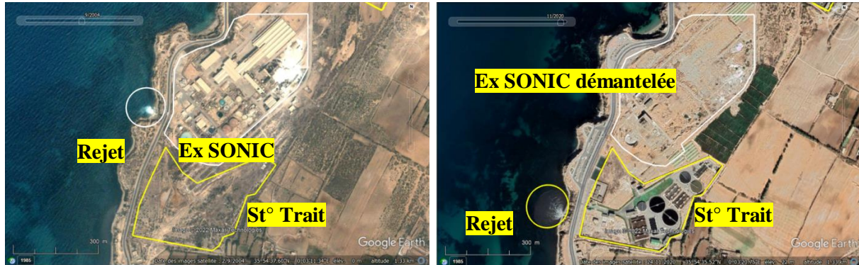
Figure 42. Station de traitement des eaux usées (2004 & 2022)
