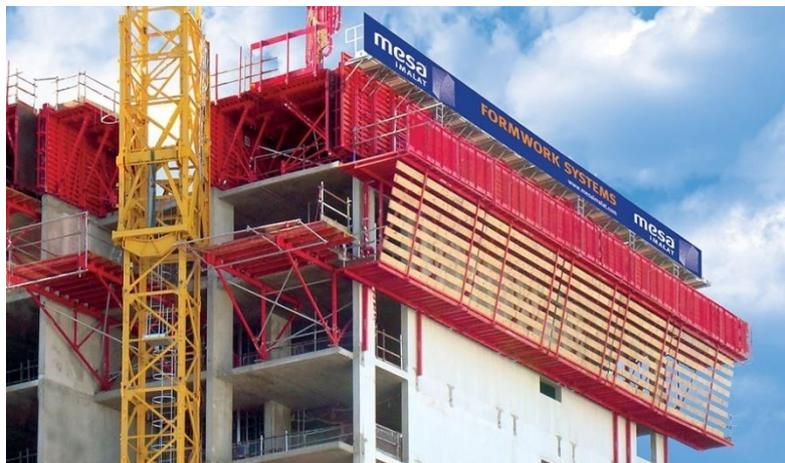
**Figure 1.1 : système coffrage**
