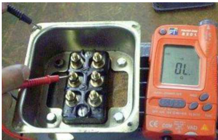
Figure(IV.5) : L'isolement des bobines par rapport à la terre.
