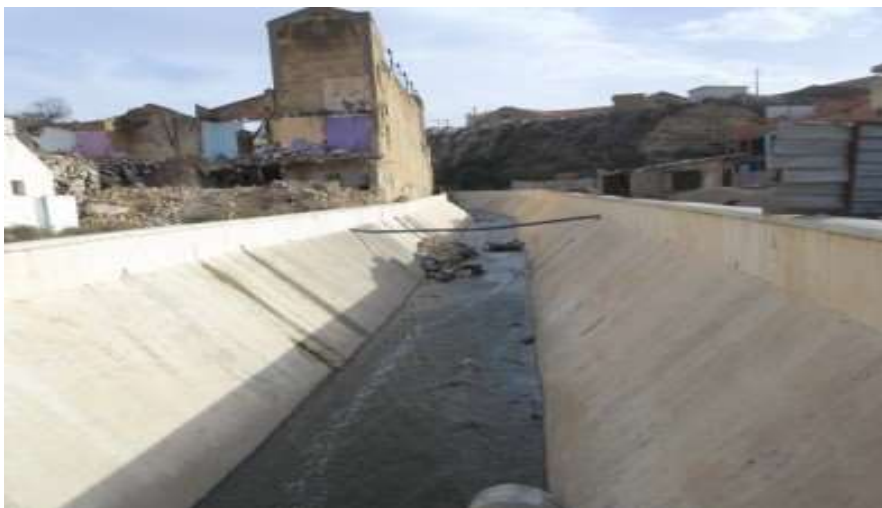
Figure I.7 : Canal principal de l'oued Ain Safra avant aménagement
