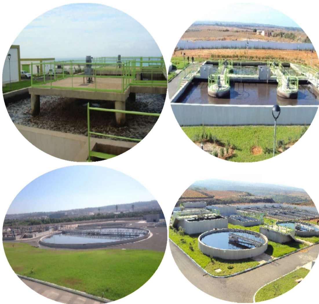
Figure I.9 : Stations d'épuration STEP de Mostaganem
