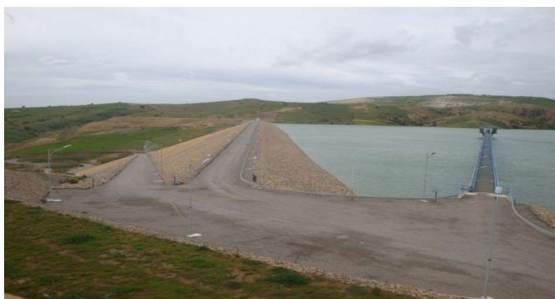
Figure I.1 : Barrage de KERRADA d'une capacité de 70 millions m 3
