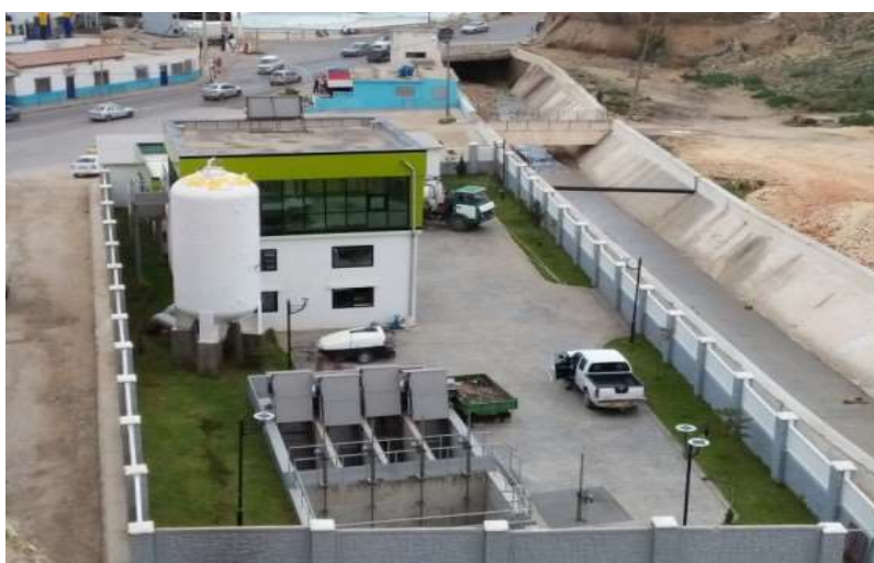
Figure I.5 : Station de relevage d'Ain Sefra
