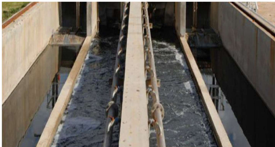
Figure II.4 : Dispositif de dessablage et de déshuilage
