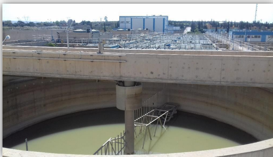
Figure II.10 : Epaississeur de boue
