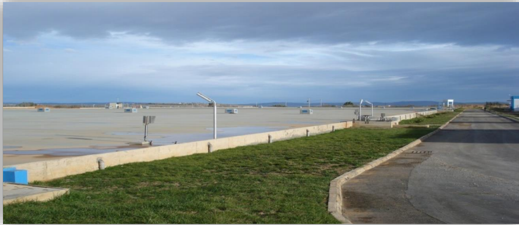
Figure. II.9 : Réservoir de stockage (A/B)
