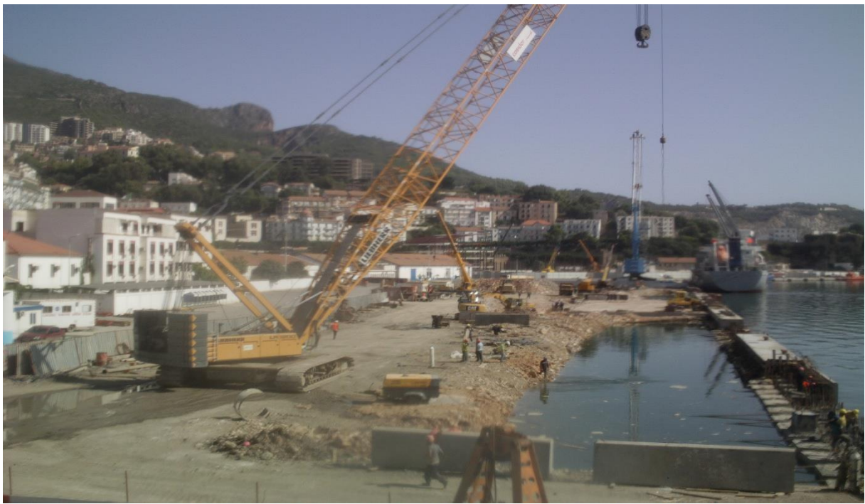
Photo n° 19- Construction d’un nouveau quai-
