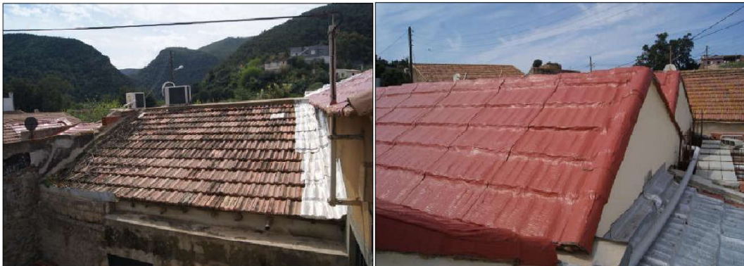
Fig. 2.23 - Vues du toit de la mosquée Sidi Bel Abbas.
