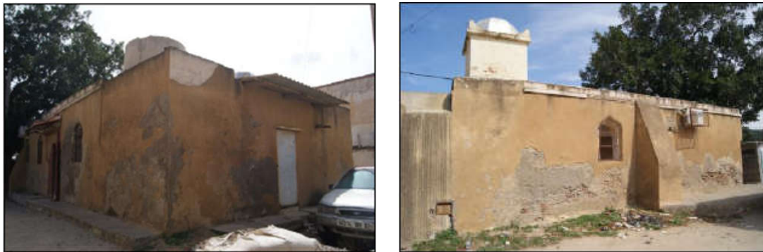
Fig. 2.15 - Façades extérieures de la mosquée Lalla Aziza.
