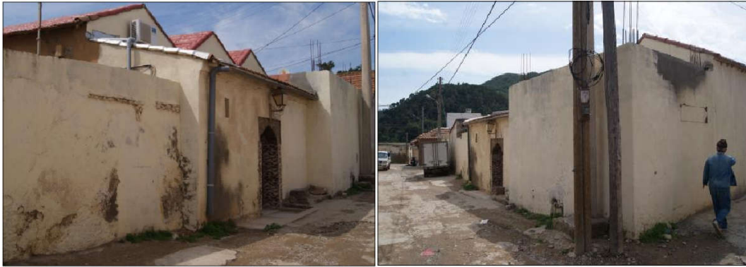
Fig. 2.21 - Façades extérieures de la mosquée Sidi Bel Abbas.
