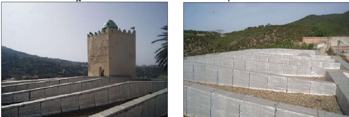
Fig. 2.12 - Vus de toiture de la mosquée Sidi Maïza
