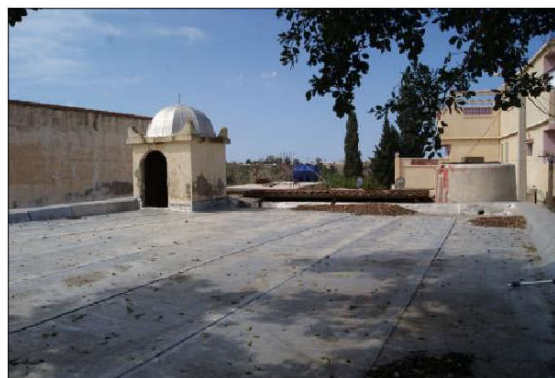
Fig. 2.17 - Vue du toit de la mosquée Lalla Aziza.
