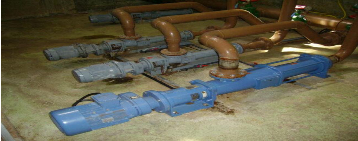
Fig28: Une pompe à vis. [38]
