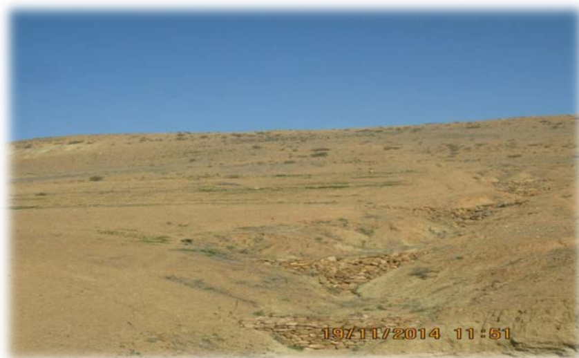
Photos 17 : Correction des ravins par des pierres sèches.
