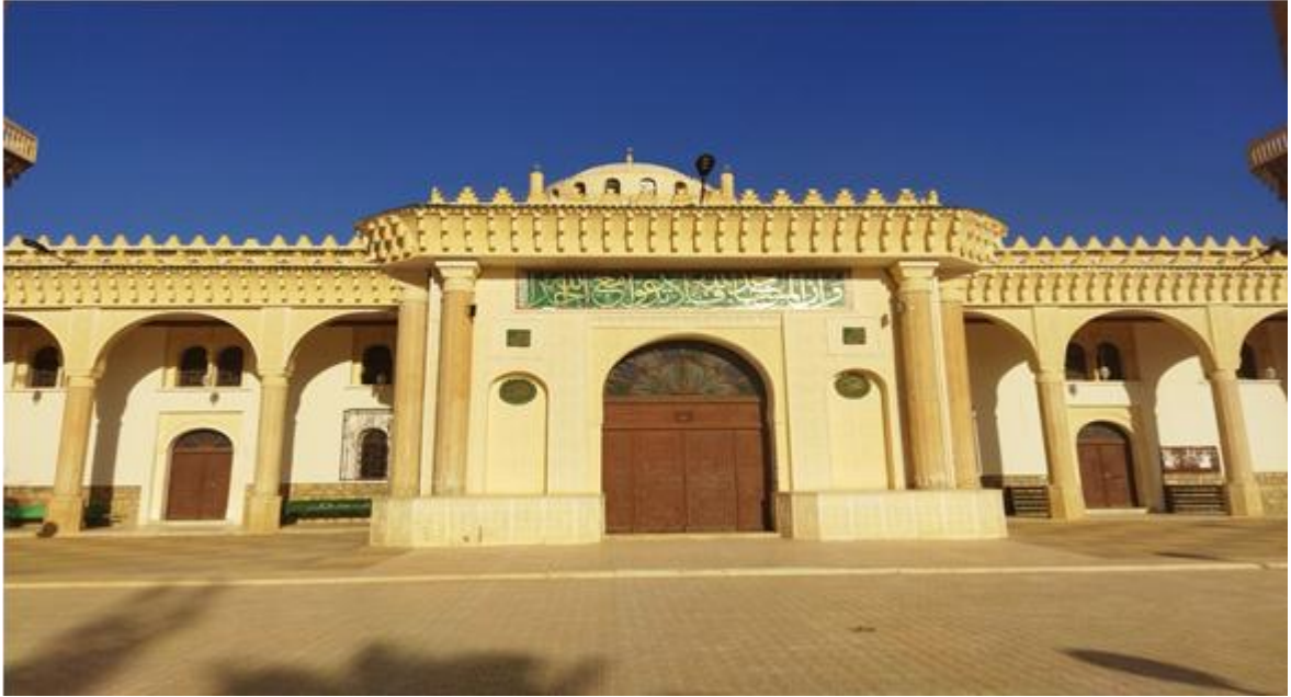
الصورة 73: مداخل المسجد 1
