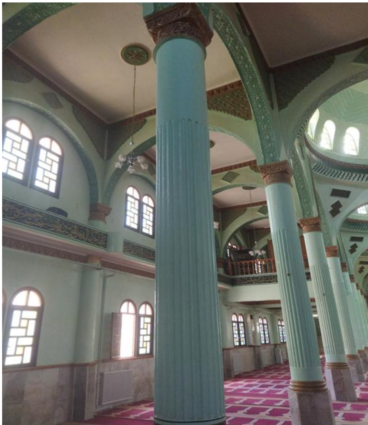
الصورة 96: أعمدة تحمل عقود 1
