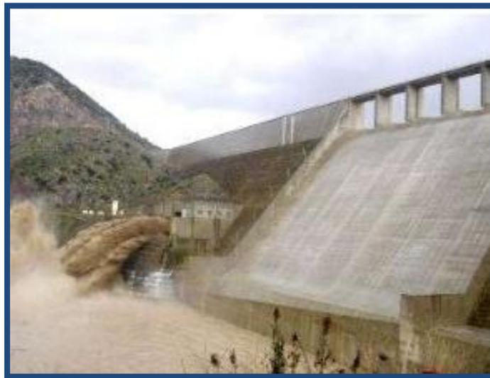
**Figure1. 22-** La suspension soutirée par les pertuis de vidange du barrage de Beni Haroun (Remini, B. 2019).
