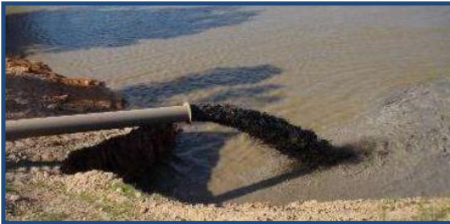
**Figure1. 17-** Dragage de barrage Bouhnifia en juin 2013 (Remini, B. 2015).
