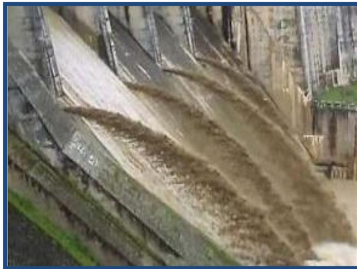
**Figure1. 20-** Soutirage des courants densité sur Barrage Zeraldas (Remini, B. 2019).
