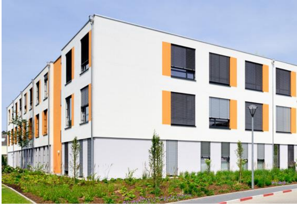
Figure 17 : Construction pour le secteur de santé. ALHO
