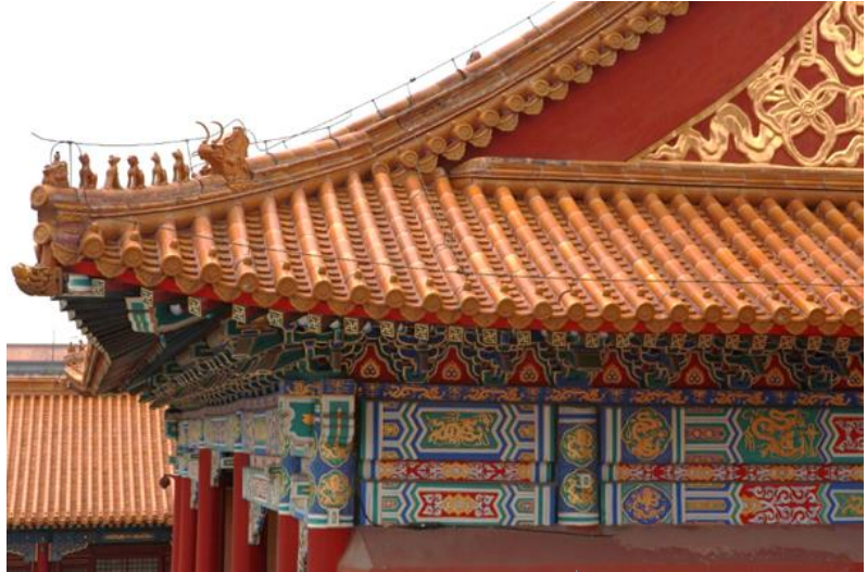
Figure 31 : Détail d'un Dougong, charpente traditionnelle chinoise
