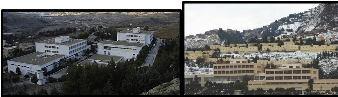
Figure 66 : le traitement de façade de Hammam Guergour [ harba-dz.com ]
