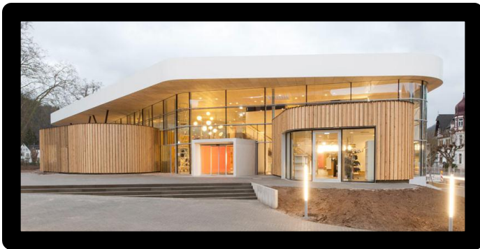
Figure 49 : la façade de bad ems.
