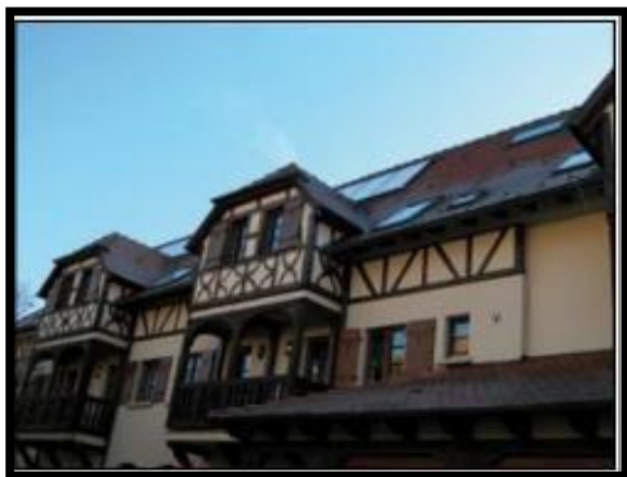
Figure04 : capteurs solaire. HOTEL Au HEIMBACH à LEMBACH.[ www.energivie.fr ]
