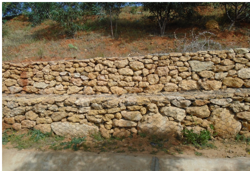
Planche 13 : Gabion en escalier de notre zone d'étude (I.BENHACHEM,2017)
