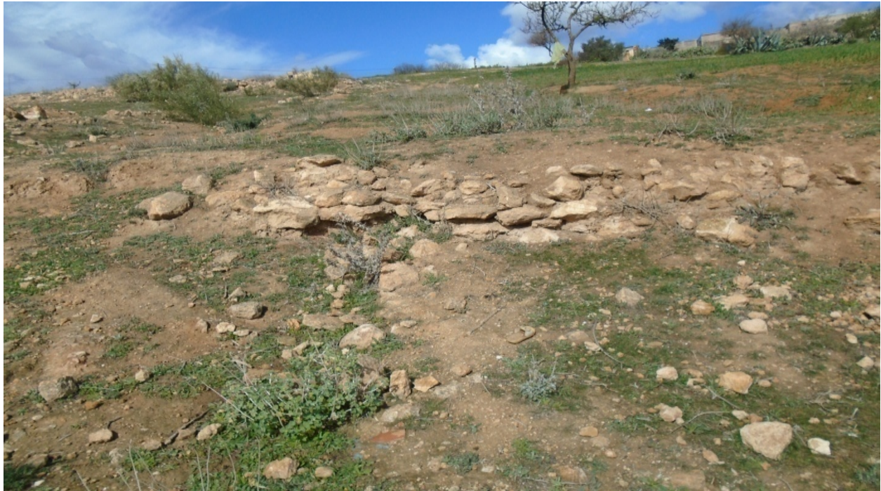
Planche 5 : Murettes en pierres sèches (I.BENHACHEM, 2017)
