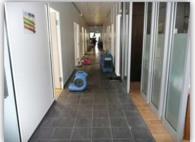
Opération de séchage des locaux humides
