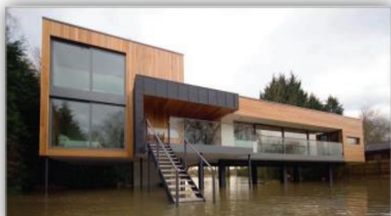
Figure 88: Eriger un bâtiment au-dessus de la ligne d'eau de crue (construction sur pilotis).
