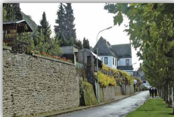
Figure 72: Mur de protection contre les crues du Rhin.
