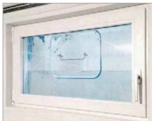
Figure 91: Fenêtre anti-inondation .
