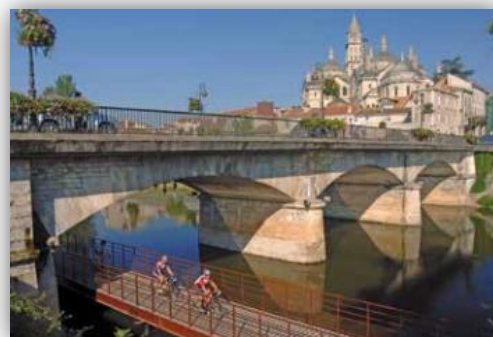
Figure 83: Exemple de l'aménagement des berges réalisation d'une passerelle pour piétons .
