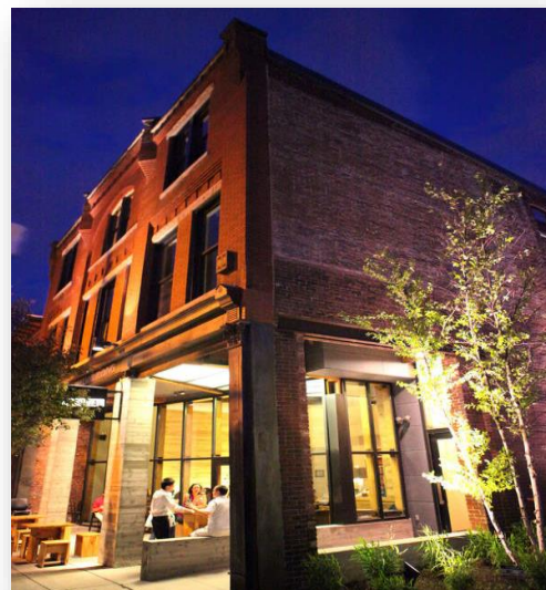
Figure 79: la façade sud du bâtiment
