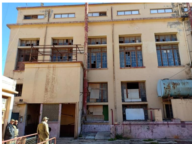
Figure 55 : Façade intérieure du bâtiment n 01
