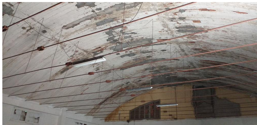
Figure 57 : la voute du bâtiment n 09 de l'intérieur
