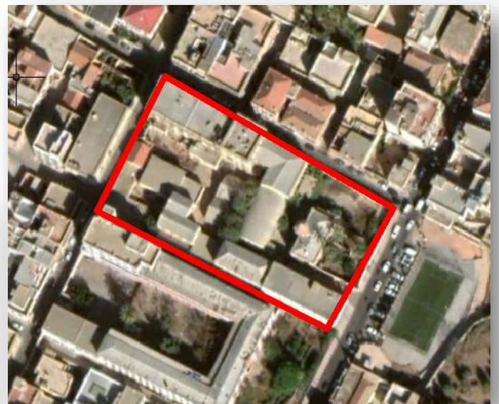
Figure 35 : Vue aérienne du SNTA
