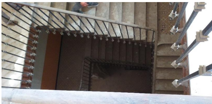
Figure 59 : L'escalier du bâtiment n 01
