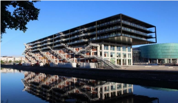
Figure 72: la façade nord source : https://www.construiracier.fr/architectures/immeubles-de-logement/les-docks-entrepot-seegmuller-strasbourg/
