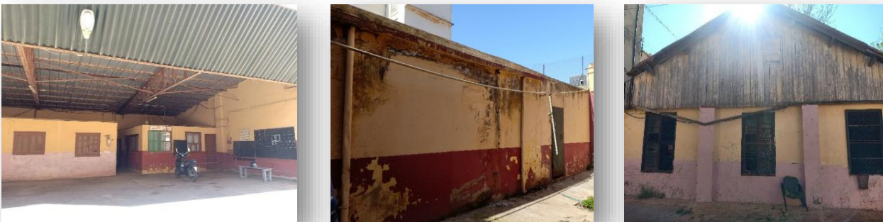
Figure 64 : Bâtiments à démolir
