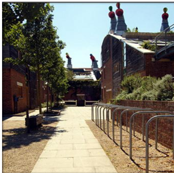
Figure 42 : parkings à vélos du BEDZED. (couché. (sd) ,2016)
