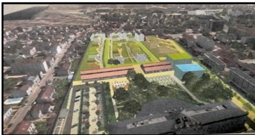
Figure 79: Le quartier après l'intervention. (Exp architectes , 2017 )
