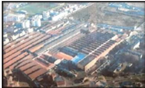
Figure 61 : Démolition du CHANDON. (DGAU ET DDU, 25 NOVEMBRE 2020)
