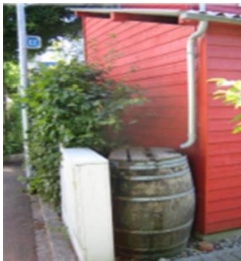
Figure 22 : les citernes de récupération des eaux. (Eau de pluie de récupération. (sd))
