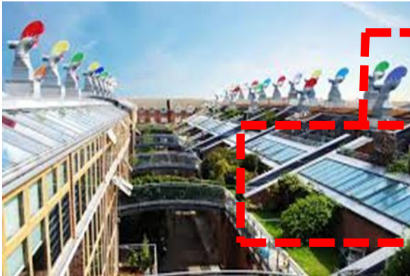
Figure 37 : panneaux photovoltaïques du BEDZED (couché. (sd))
