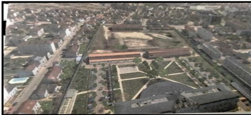
Figure 78 : Le quartier avant l'intervention. (Exp architectes , 2017 )
