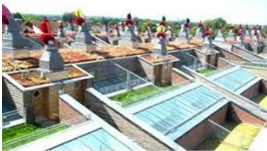
Figure 33 : le toit du BEDZED. (déclic . 19 mars 2013).
