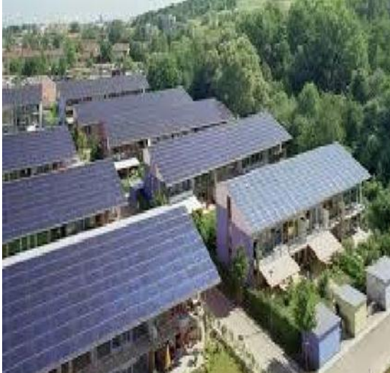
Figure 18 : les panneaux photovoltaïques. (Chapelle, S, 5 septembre 2009)
