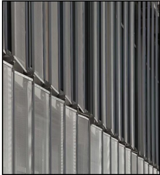
**Figure 27 / 28 :** schéma présente les panneaux d'ombrage fixes dans les façades.
