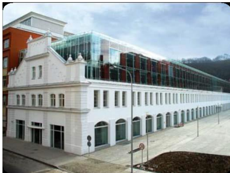
Figure 14 : vue de l'extérieur de la tôlerie
