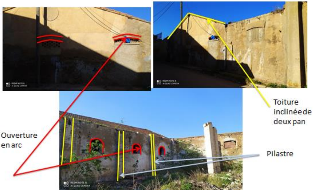
Figure 46 : Façade de 2eme hangar
