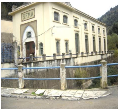
Figure 04 : vue de la centrale de Laghouat
