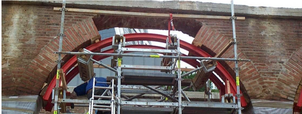
Figure 50: consolidation des ouvertures des arènes Sources : Pierre Engel
