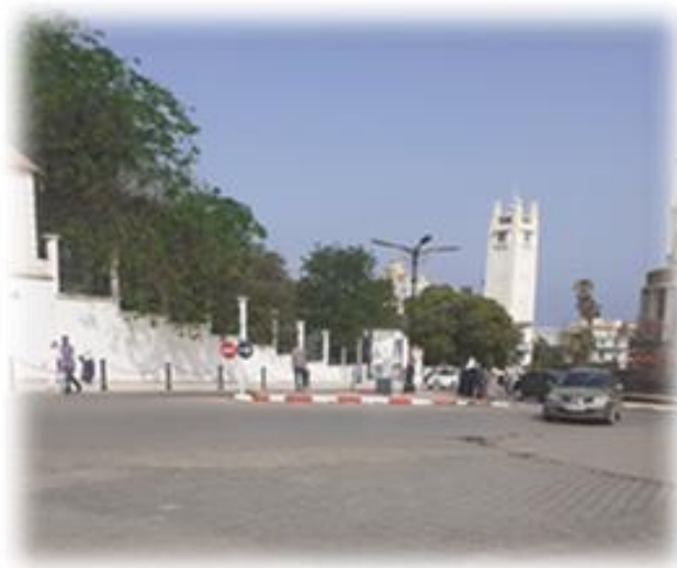
Figure 62.mur de clôture du jardin AEK
