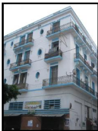
Figure 48. Vue après la réhabilitation de l'immeuble d'habitation N°4.
