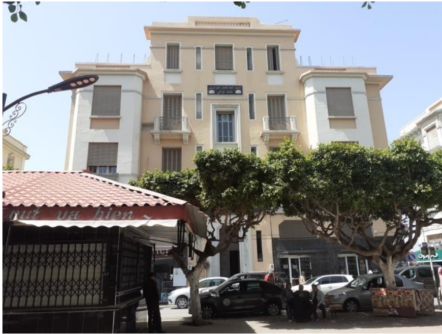
Figure 41. Vue de l'immeuble d'habitation N°3.
