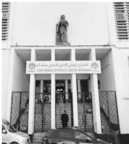
Figure 30.Vue de l'immeuble du C.R.M.A
