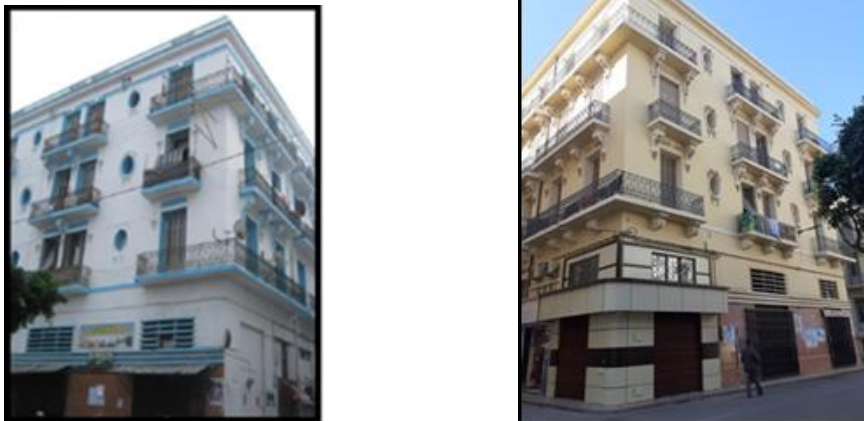
Figure 66. Vue avant et après la réhabilitation
