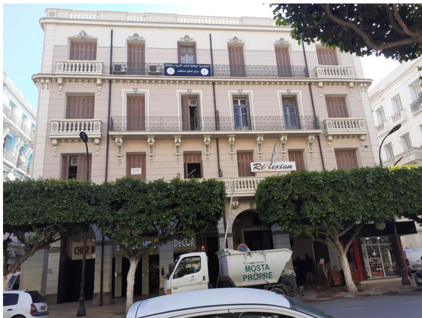
Figure 21. Vue de l'immeuble d'habitation N°1.
