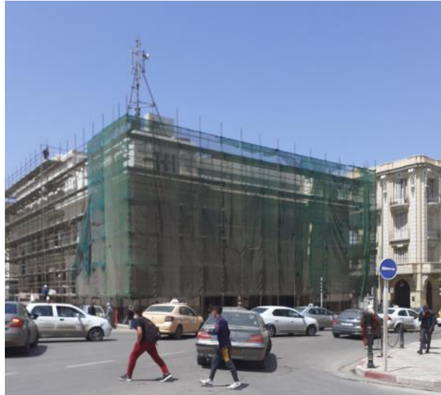
Figure 3 Bâtiments durant les travaux de réhabilitation-Centre-ville Mostaganem
