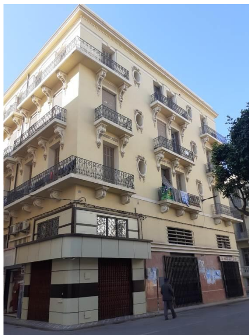
Figure 4 Bâtiments avant les travaux de réhabilitation-Centre-ville Mostaganem
