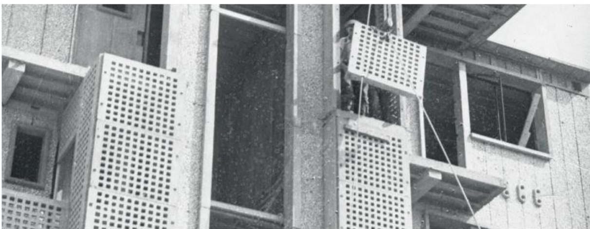
Fig05. La fixation des panneaux de façade en béton vibré incrustés de galets de marbre.
