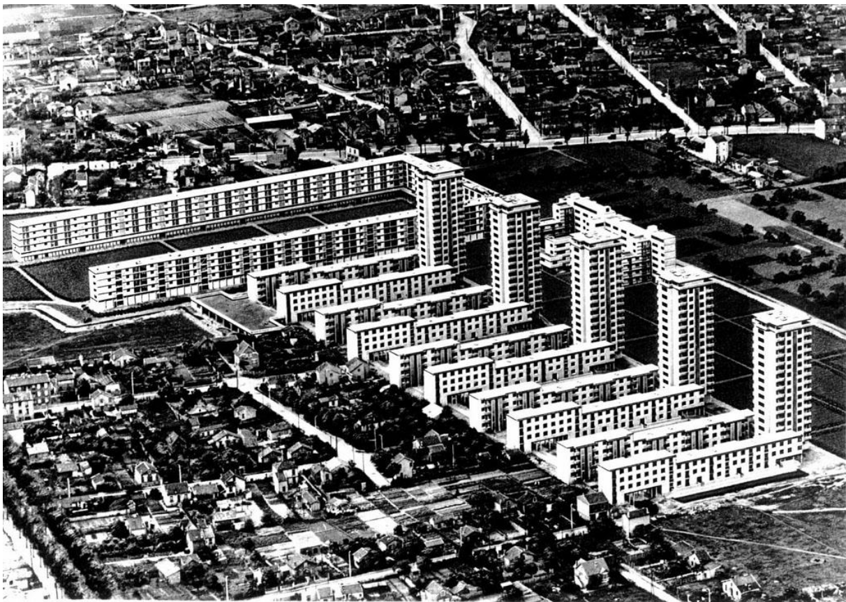
Fig07. Vue d'ensemble de la cité de la Mouette.
