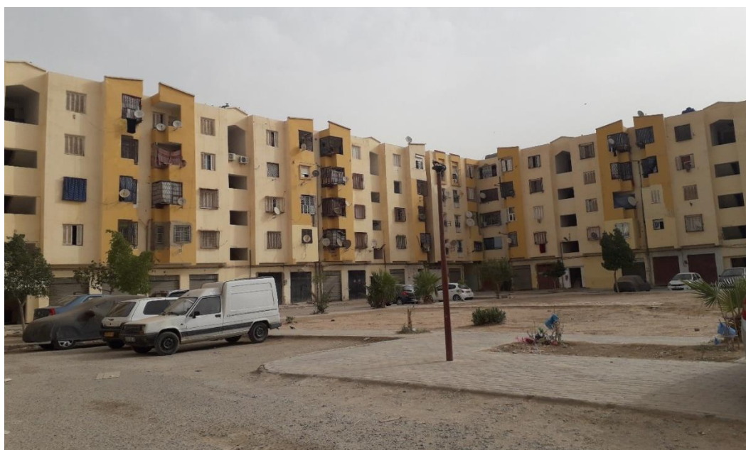
Fig26. La cour centrale de l'ilot.
