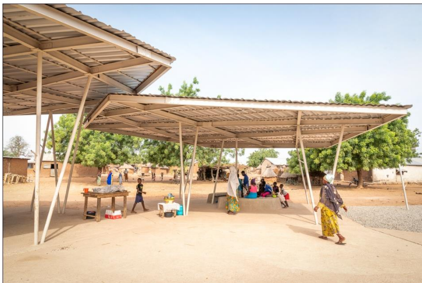
Figure 19 : la couverture du marché Source : https://divisare.com/
