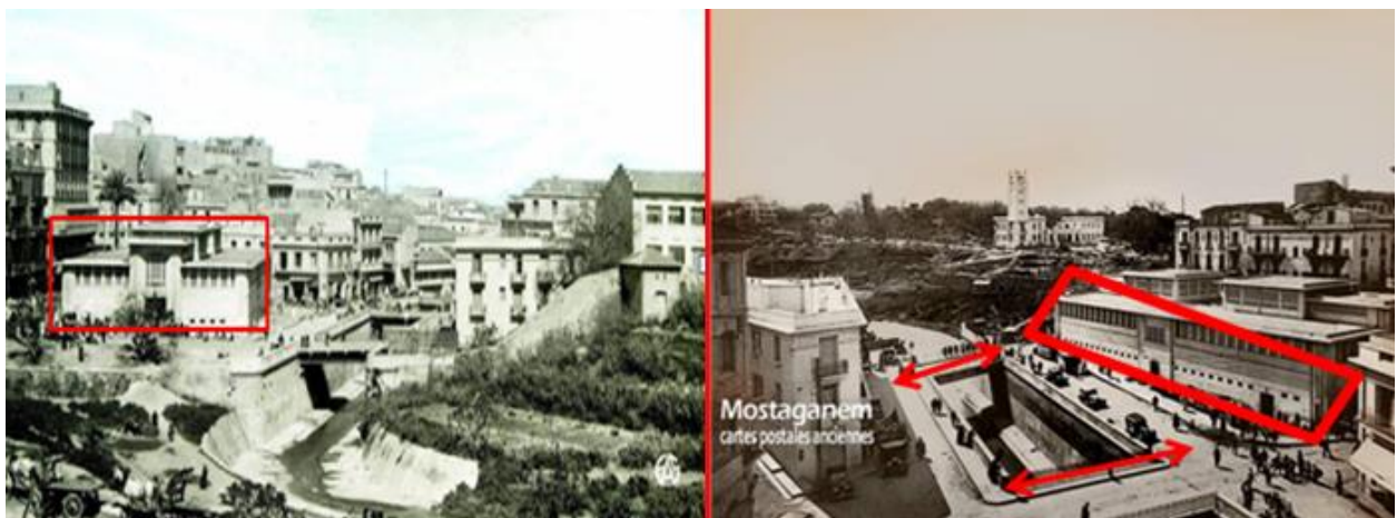
Figure 26 : le marché couvert et les trois ponts Source : Mostaganem hier
