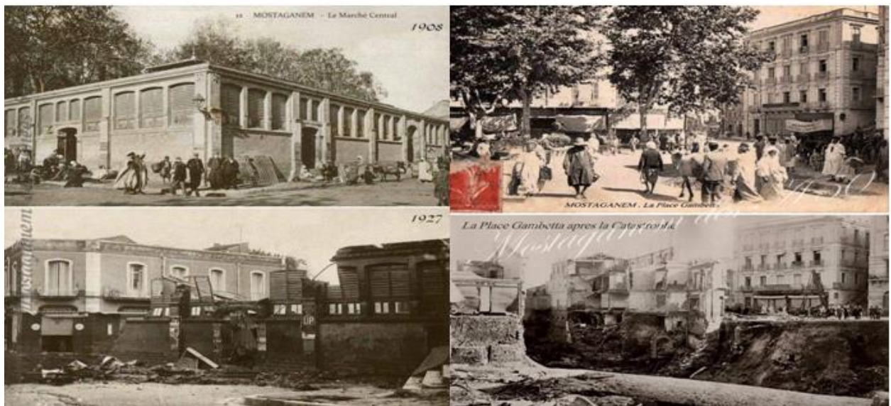
Figure 24 :Vues sur une partie touchée par les inondations
