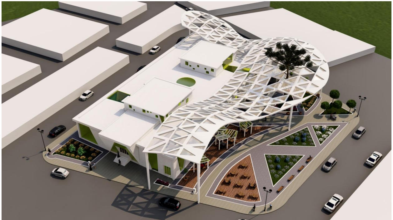
Figure 39 : vue sur le marché
