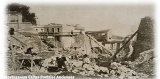
Figure21 : vue sur une partie touchée par les inondations,
