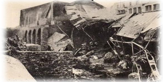
Figure22 : vue sur une partie touchée par les inondations, www.delcampe.fr
