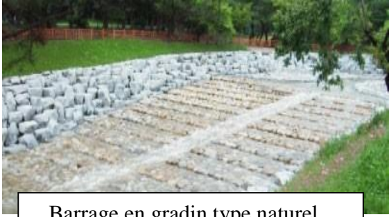
Barrage en gradin type naturel
