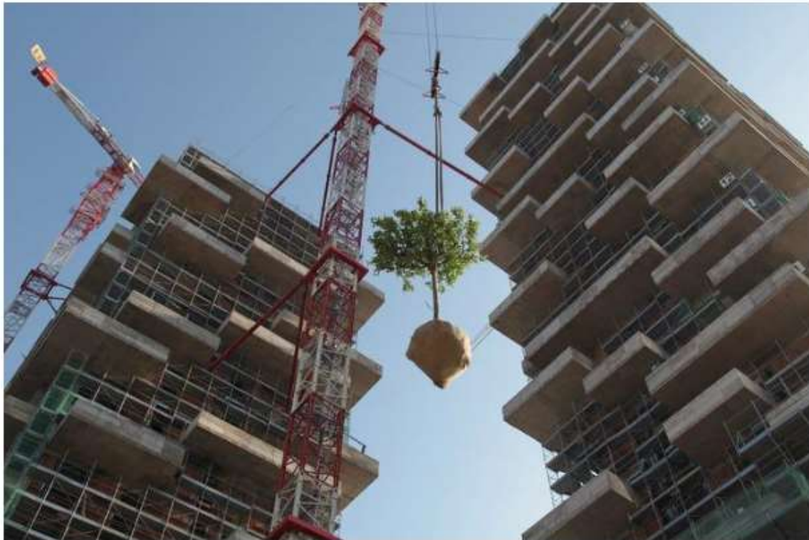
Figure 84 Photographie du Bosco Verticale lors de la mise en place des arbres sur les balcons.
