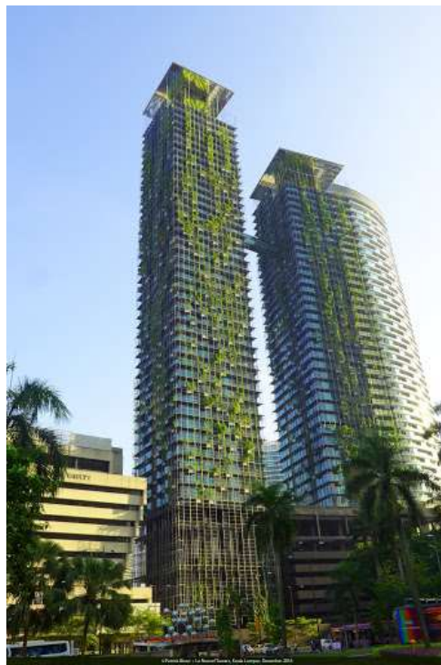
Figure 83 Mur végétal réalisé par Patrick Blanc en Malaisie
