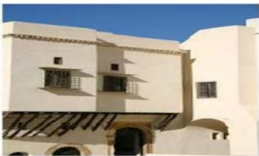
Figure 19: Encorbellements, « kbou » Source : Atek Amina 2012
