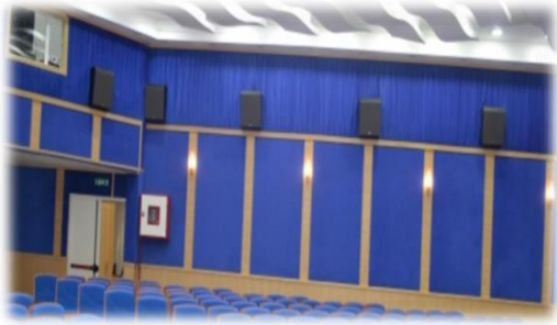
Rénovation des murs de la salle de projection
