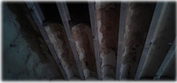
Plancher nervuré à mauvaise état en 2012
