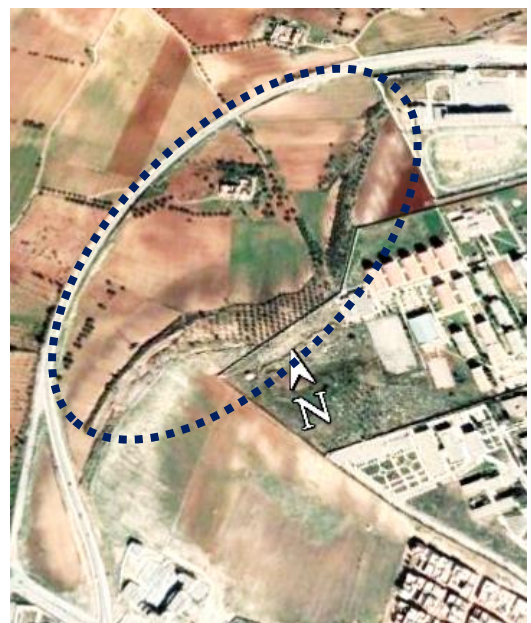
Figure 61 : bassin nord du pôle Mamounia Source : Google Earth
