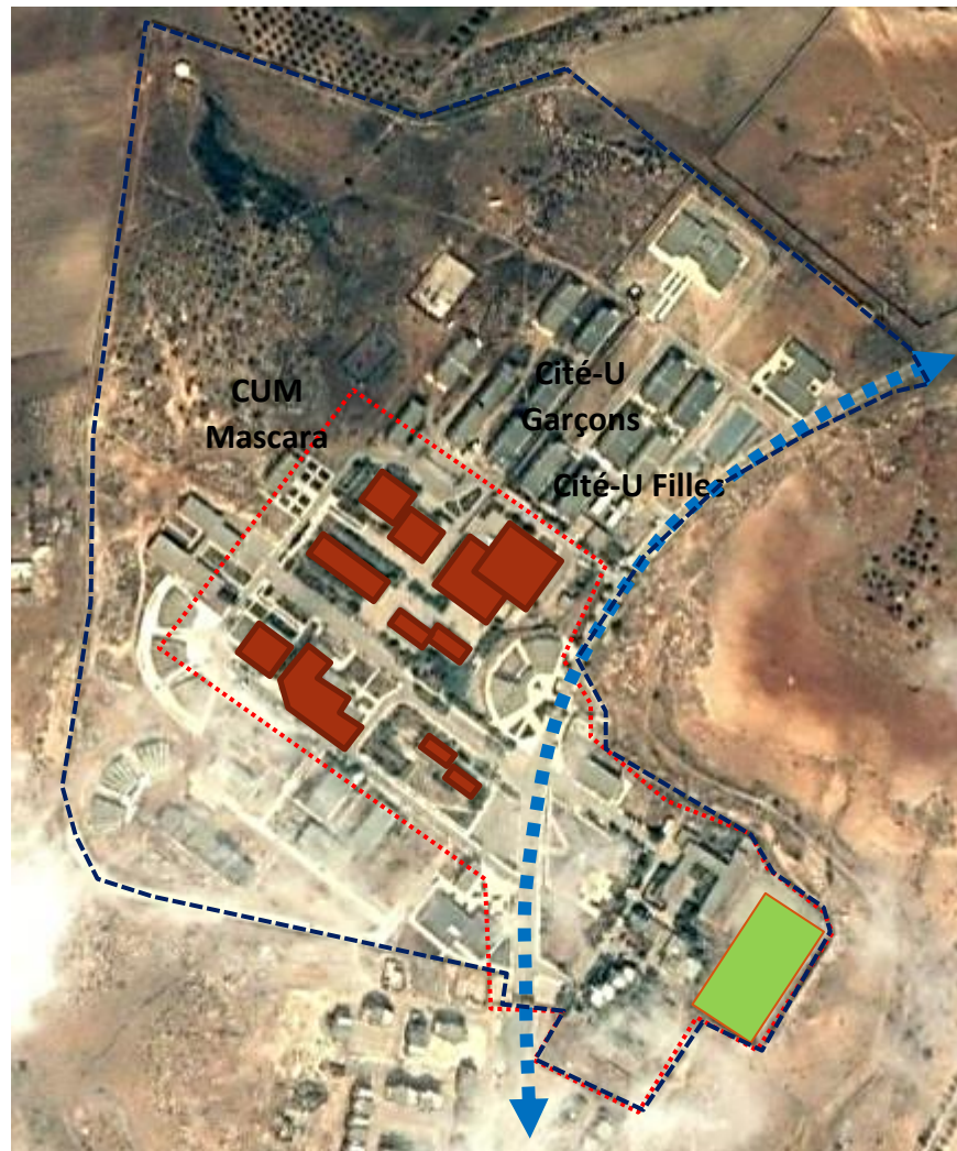
Figure 50 : Centre Universitaire de Mascara (CUM), avec les 02 cités universitaires Source de la carte : Google Earth 2014, interprétée par l'auteur du mémoire
