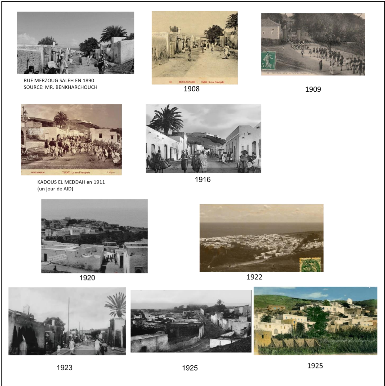
Figure 1.7 : Vues sur la rue Merzoug Saleh. Source : Mr. BENKHARCHOUC. H.
