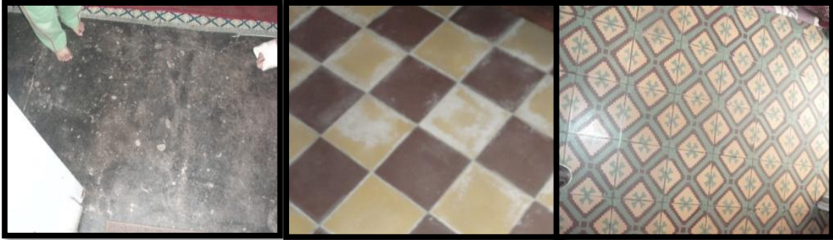
photo 27: revêtement du sol
