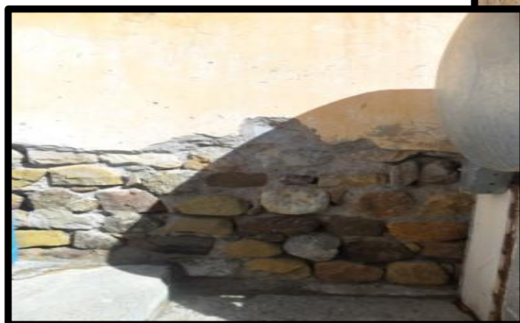
photo 23 murs porteurs source : d'après l'auteur
