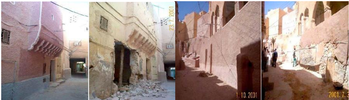
photo 36 Avant la restauration Après la restauration
