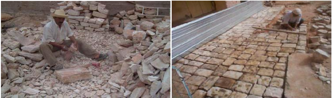
photo 35 Utilisation de matériaux écologiques.
