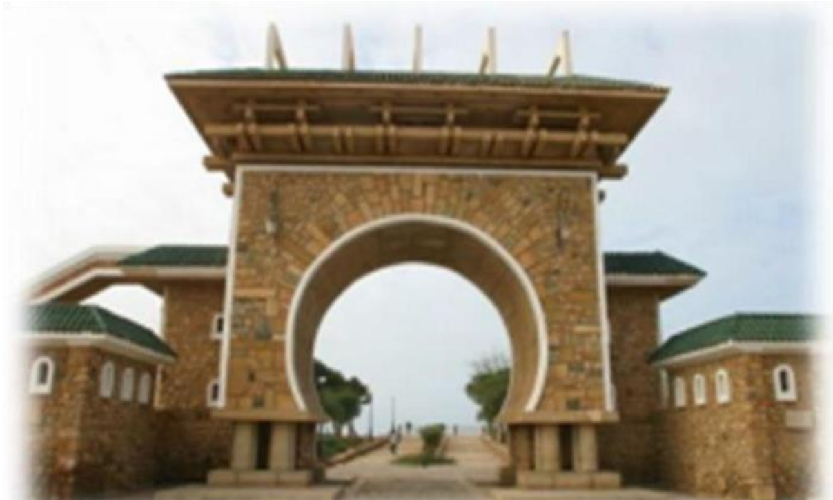
Figure 1 : le rempart semi-circulaire face à Tigditt (Source approche urbaine).
