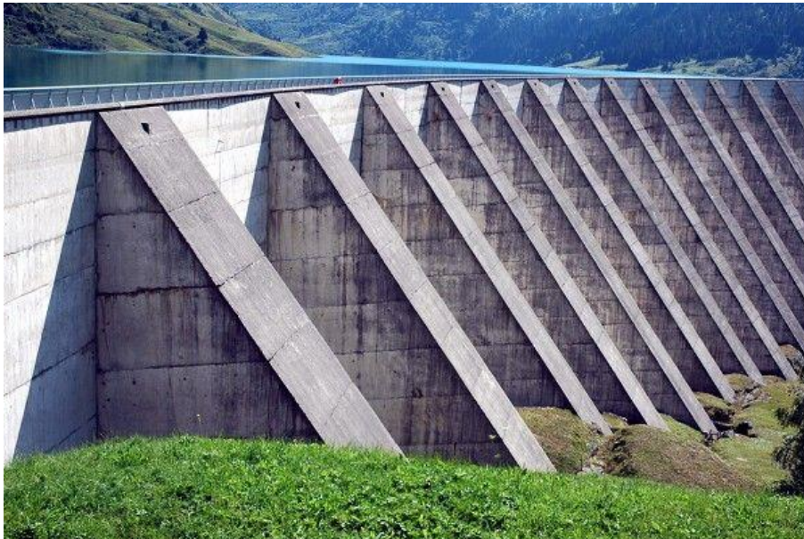
Figure11.19 Les barrages à Contreforts [34]
