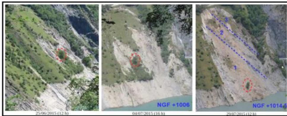
Figure 1.10 Glissement de terrain en France [10]
