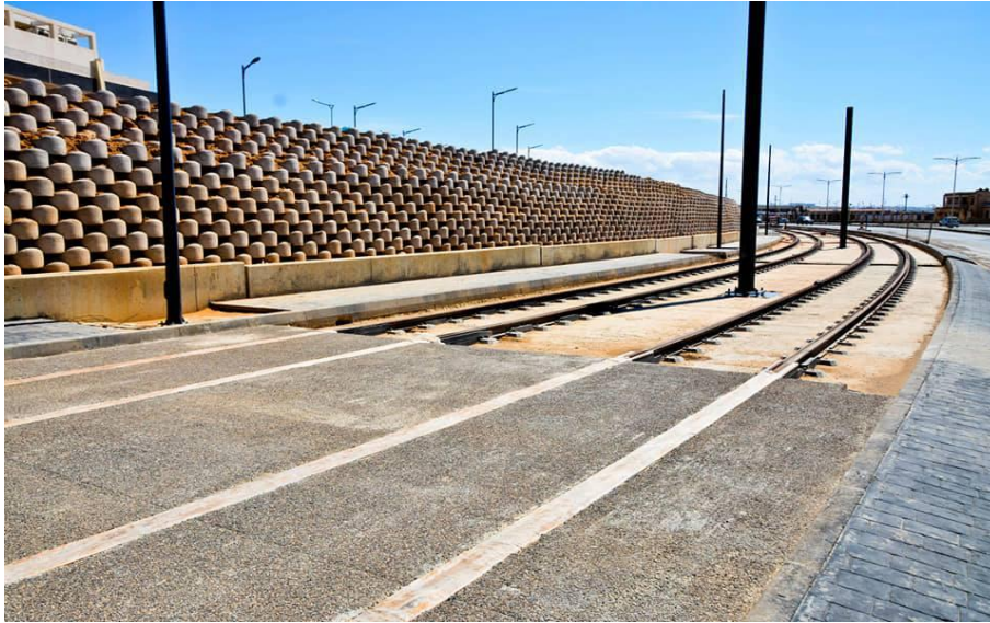
Figure1I.15 Ouvrage de soutènement à Mostaganem [31]
