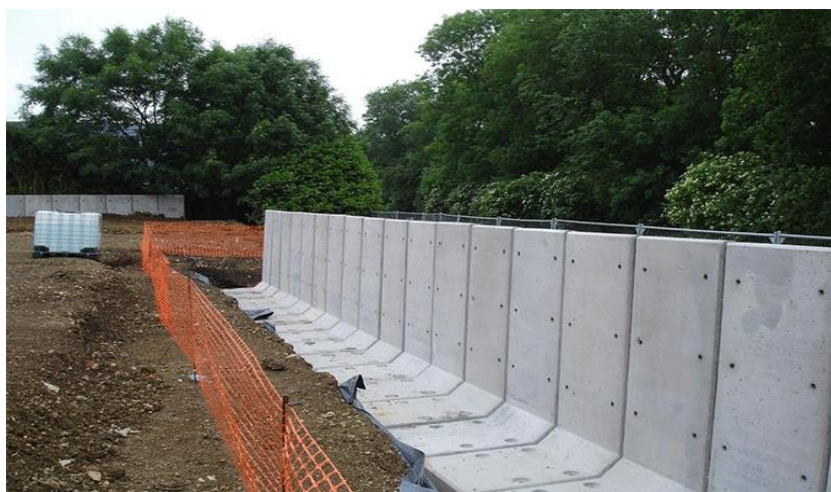
Figure 1.14 Un ouvrage de soutènement [30]
