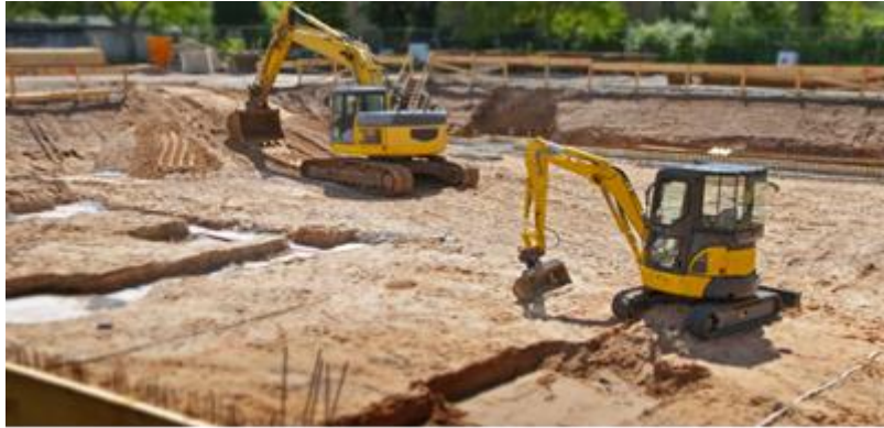
Figure II.1 Les travaux de terrassement [12]
