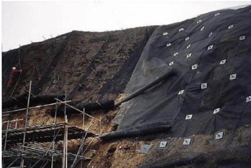
FigureII.20 Un versant stabilisé par clouage [35]
