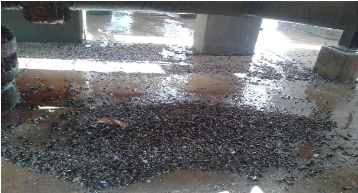
**Fig.II.3.** Les moules entraînées par l'eau de mer, piégées dans l'échangeur E-514.
